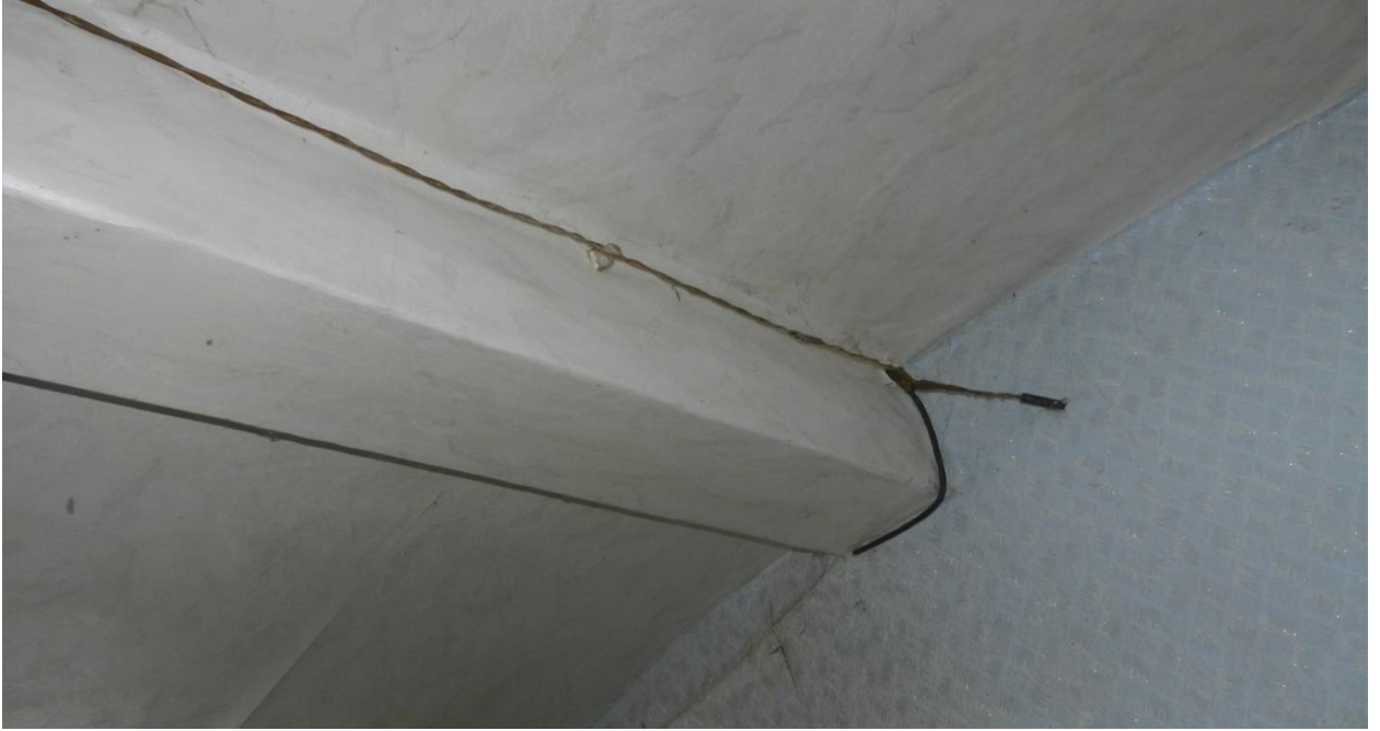
Рис. 13. Открытая электропроводка
