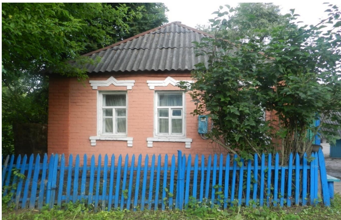
Рис. 3.2. Обследуемый жилой дом
