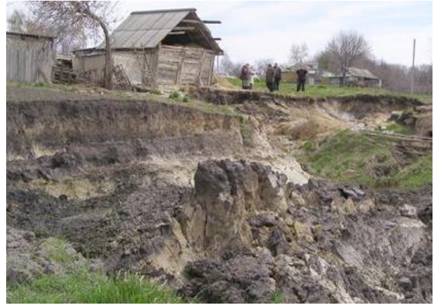
Рис. 2.11. Оползень в с. Щербаково
