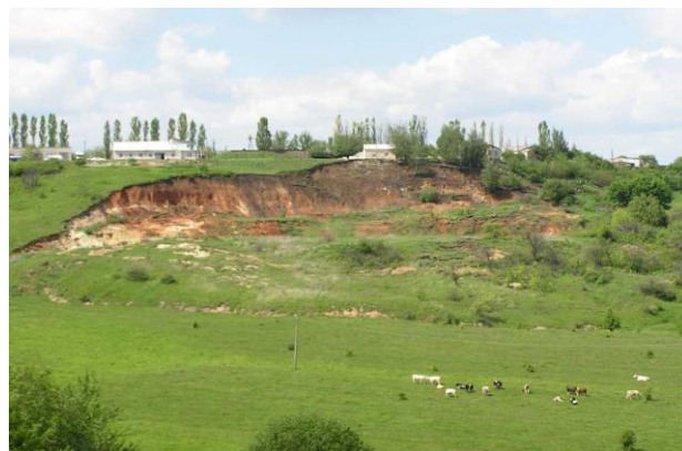
Рис. 2.7. Оползень в пос. Дубовое
