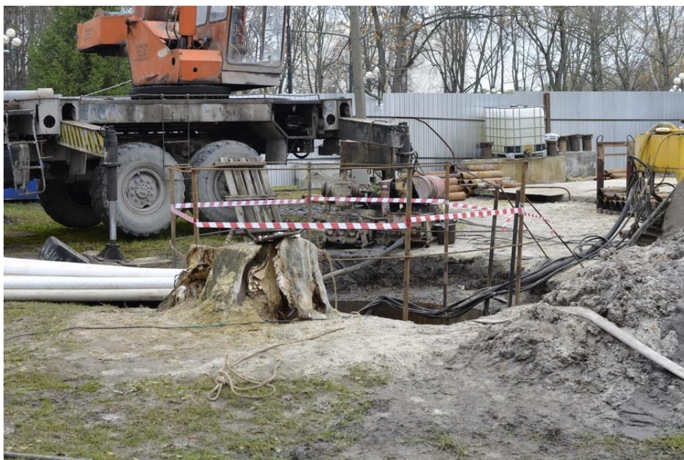
Рис 2.3 Строительство лучевой дренажной системы
