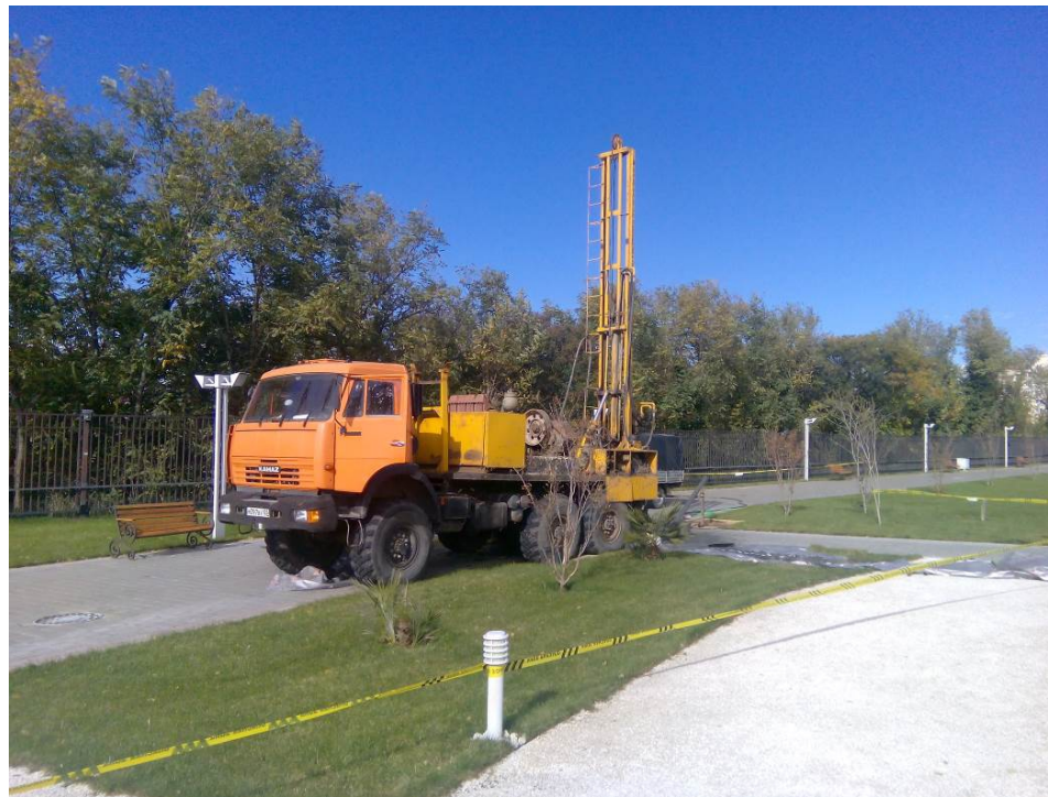
Рисунок 3.3 – Буровая установка УРБ-2А2
