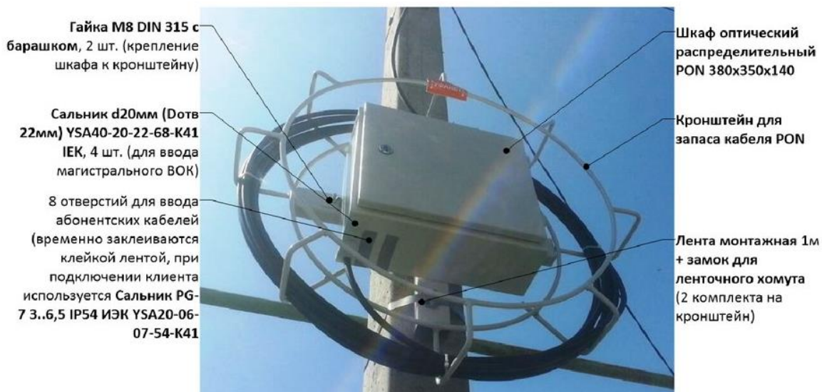
Рисунок 4.10 – Установка ОРШ на столбе
