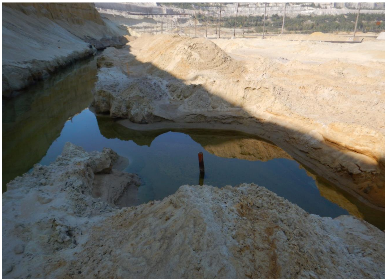
Рис. 2.3- Прибортовый дренаж с сбросной скважиной (Северный борт карьера представлен песками альб-сеноманского водоносного горизонта абсолютная отметка +93)
