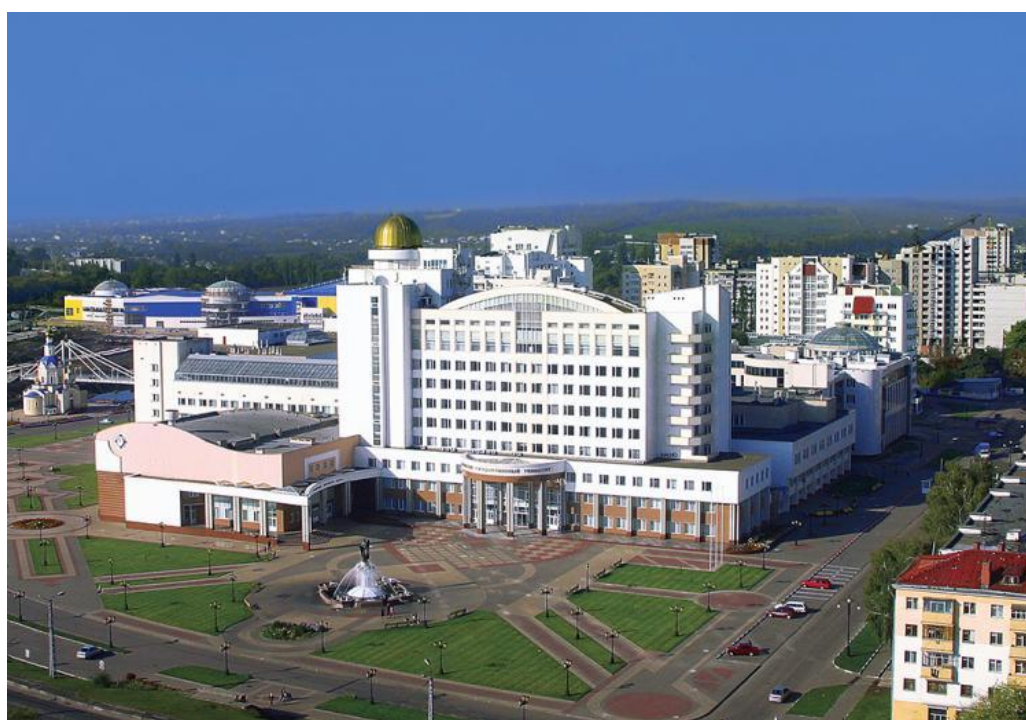
Рисунок 2.1 – Главный корпус НИУ БелГУ
