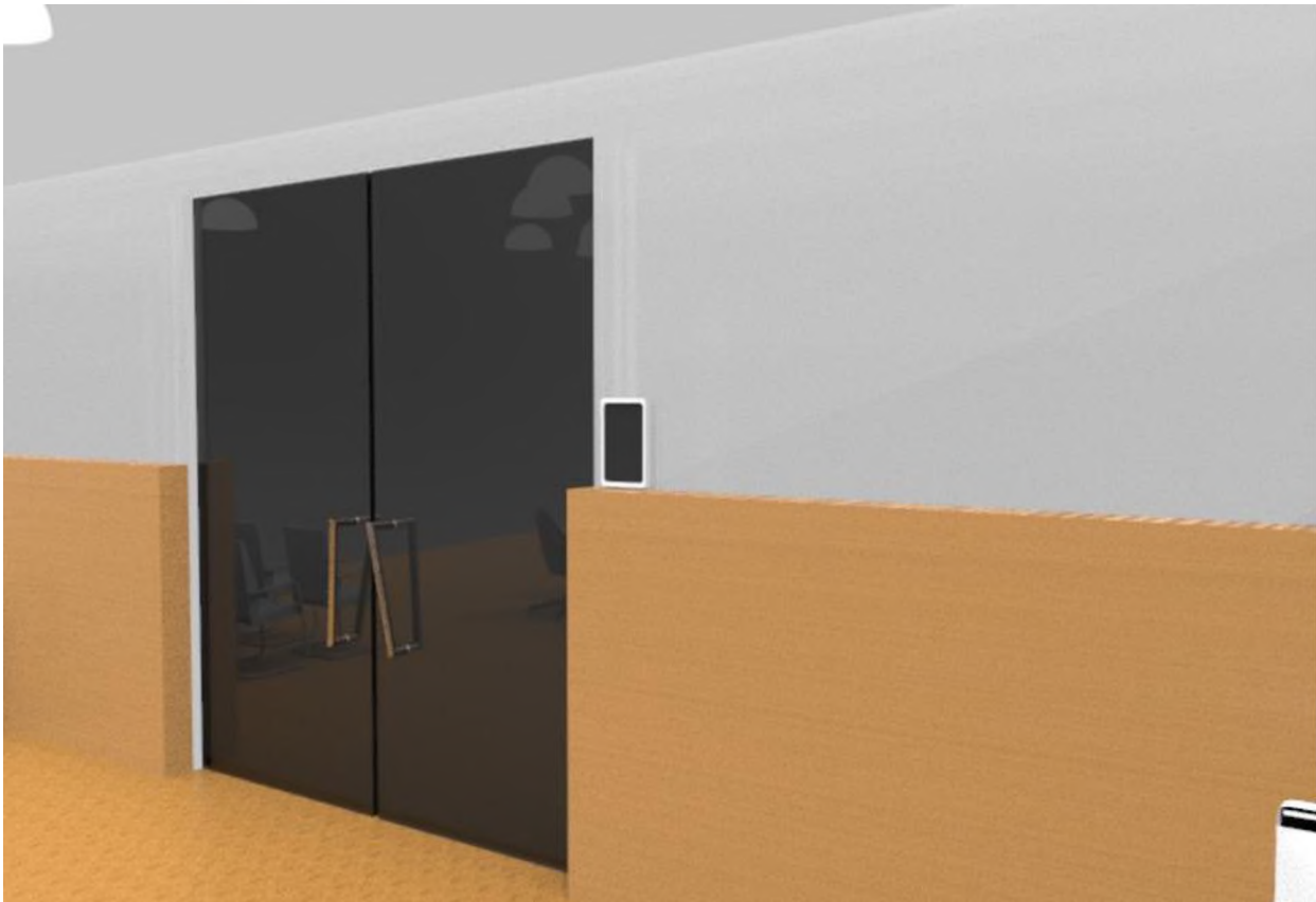
Рис. 6. Расположение устройства управления подсистемами освещения, кондиционирования и отопления в интеллектуальном зале совещаний
