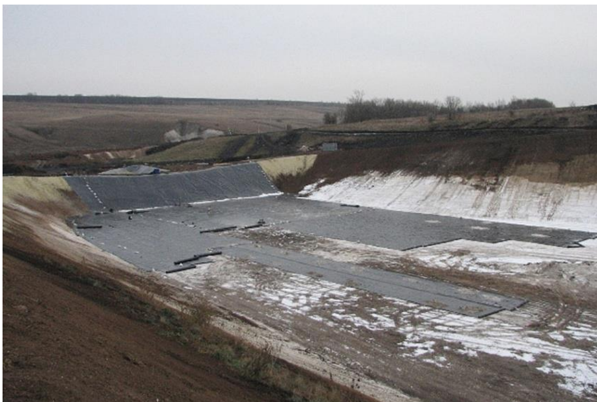
Рис. 1. Строительство Губкинского полигона ТКО (укладка геомембраны) [47]
