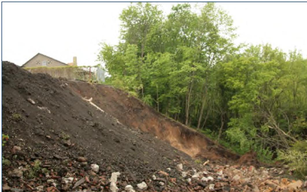
Рис. 4. Оползень на склоне овражно-балочной системы на окраине г. Короча
