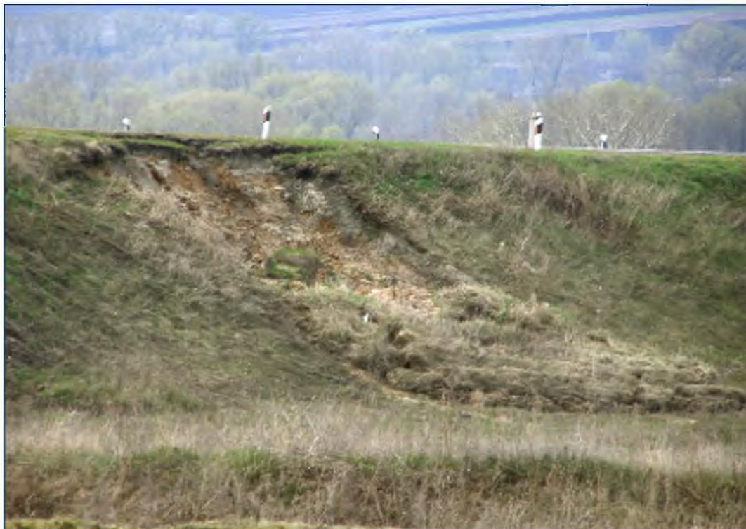
Рис.1. Оползень – поток, поражающий тело автомобильной дороги
