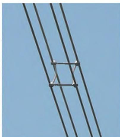
Рис 1. Цифрами на рисунке обозначены: 1 – изолятор; 2 – расщепленная фаза из двух проводов; 3 – распорка между проводами одной расщепленной фазы; 4 – провод заземления, закрепленный на верхушке опоры ЛЭН; 5 – три расщепленных фазы, расположенных на одной стороне по отношению к опоре ЛЭН и образующих одну электрическую цепь
